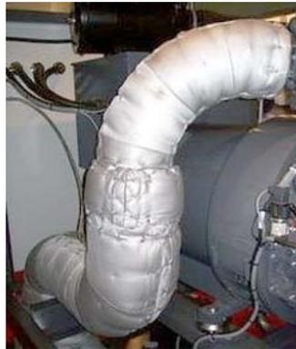
Objekt, zum Beispiel ein Ventil, wird quasi mit einer Jacke "angezogen". Das kann eigentlich jeder, dazu muss man kein Fachmann sein. Weitergehendes Informationen zu Wickelisolierungen, isowrap, textile Dämmungen finden Sie hier:
